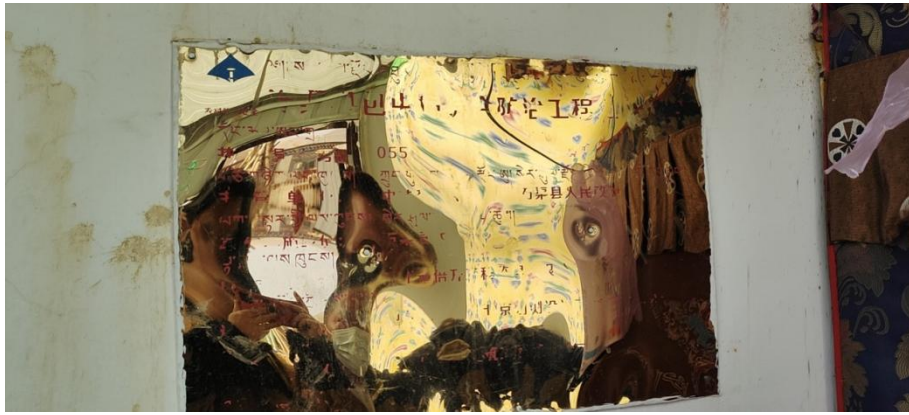
图 2、标示标牌腐蚀严重、内容模糊不清
